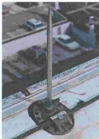
FIGURA 22.10 O pára-raios está conectado ao solo através de um fio condutor resistente, de modo que ele possa conduzir uma grande corrente para o solo, ao ser atingido por um raio. Na maior parte das vezes, a carga acaba escoando lentamente da ponta do pára-raios, impedindo a ocorrência de um raio.
